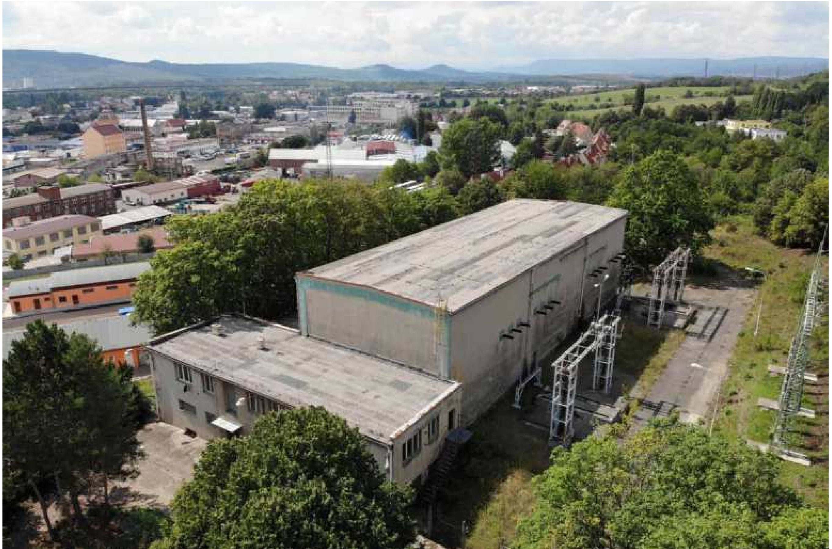
Odpojená trafostanice Spolku pro chemickou a hutní výrobu v Ústí nad Labem
